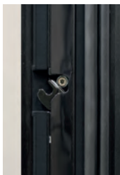
Der Verschluss mit pferdekopfförmiger Verriegelung im Rahmen
