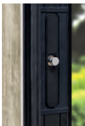
Dreidimensional verstellbares Schließblech im Türflügel
